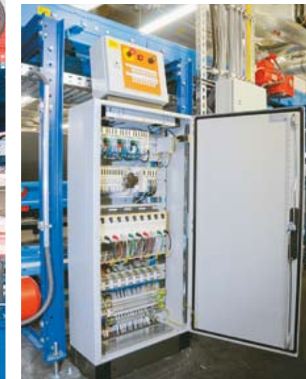
Rittal CM Kompaktschrank-System: einfacher Innenausbau dank integrierter CM Schiene an den Seitenwänden.
